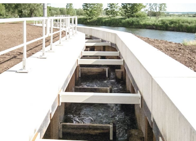
Stahlbauarbeiten für den Beckenpass einer Fischaufstiegsanlage
