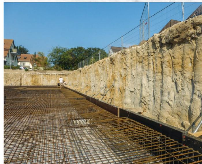
Baugrube in Wustrow – Baugrubenumschließung mittels Bodenmischverfahren
