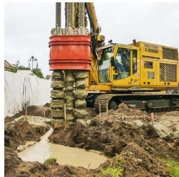
Wustrow – Bodenmischverfahren für Baugrubenverbau mit Dreifach Mischpaddel
