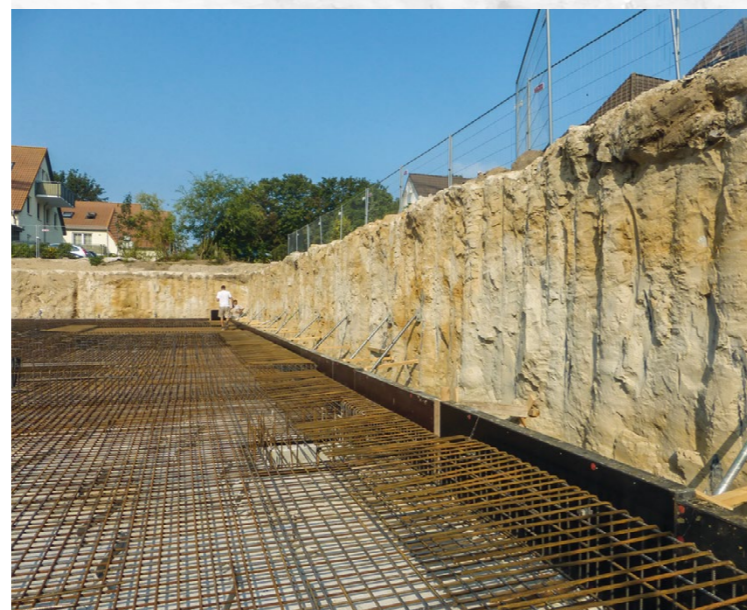
Baugrube in Wustrow – Baugrubenumschließung mittels Bodenmischverfahren
