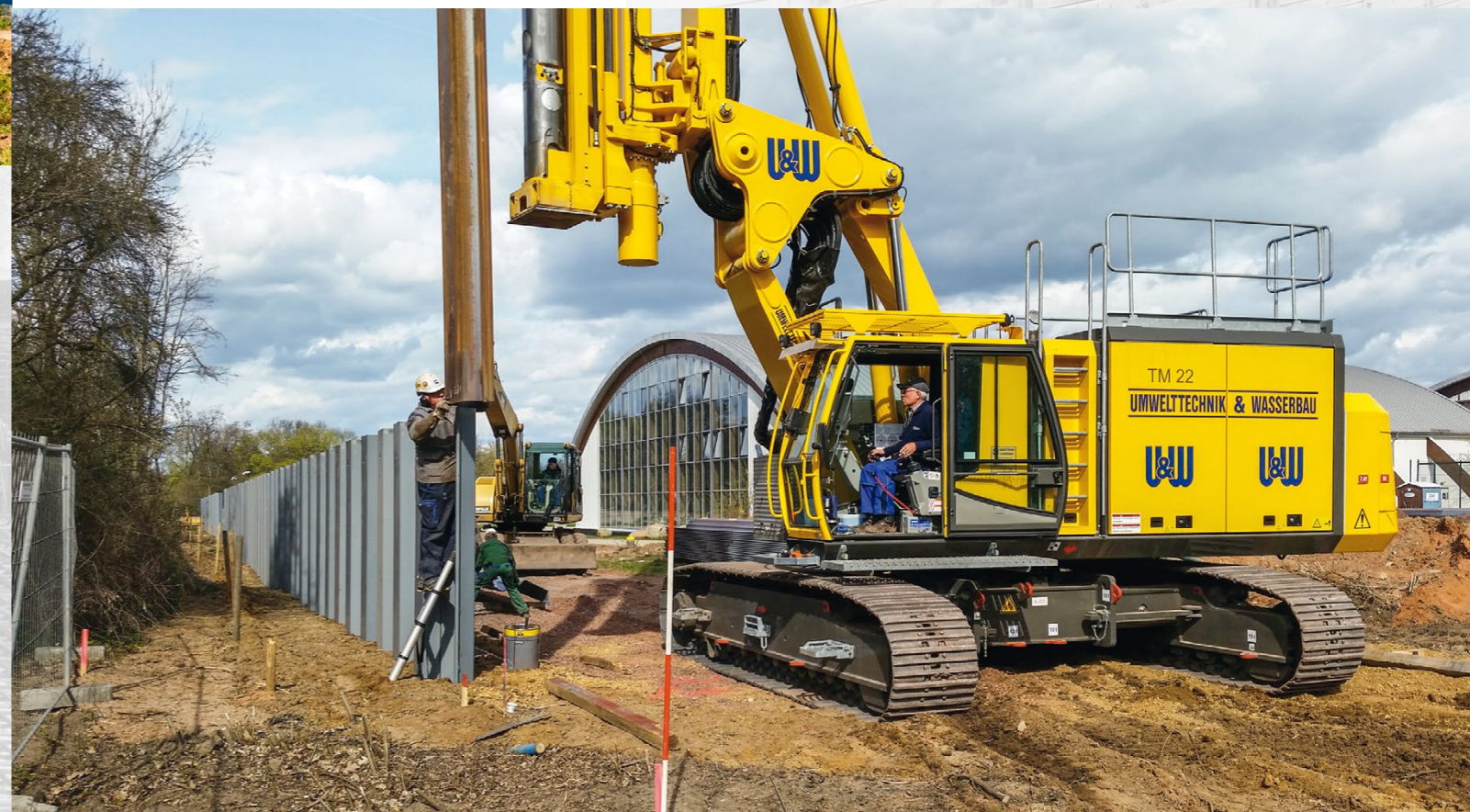
Spundwandaarbeiten Rammgerät TM 22 Hochwasserschutz Sportpark Herrenkrug Magdeburg
