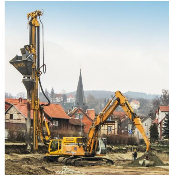
Wernigerode, Rüttelstopfverdichtung für die Gründung der Zindel-Turnhalle
