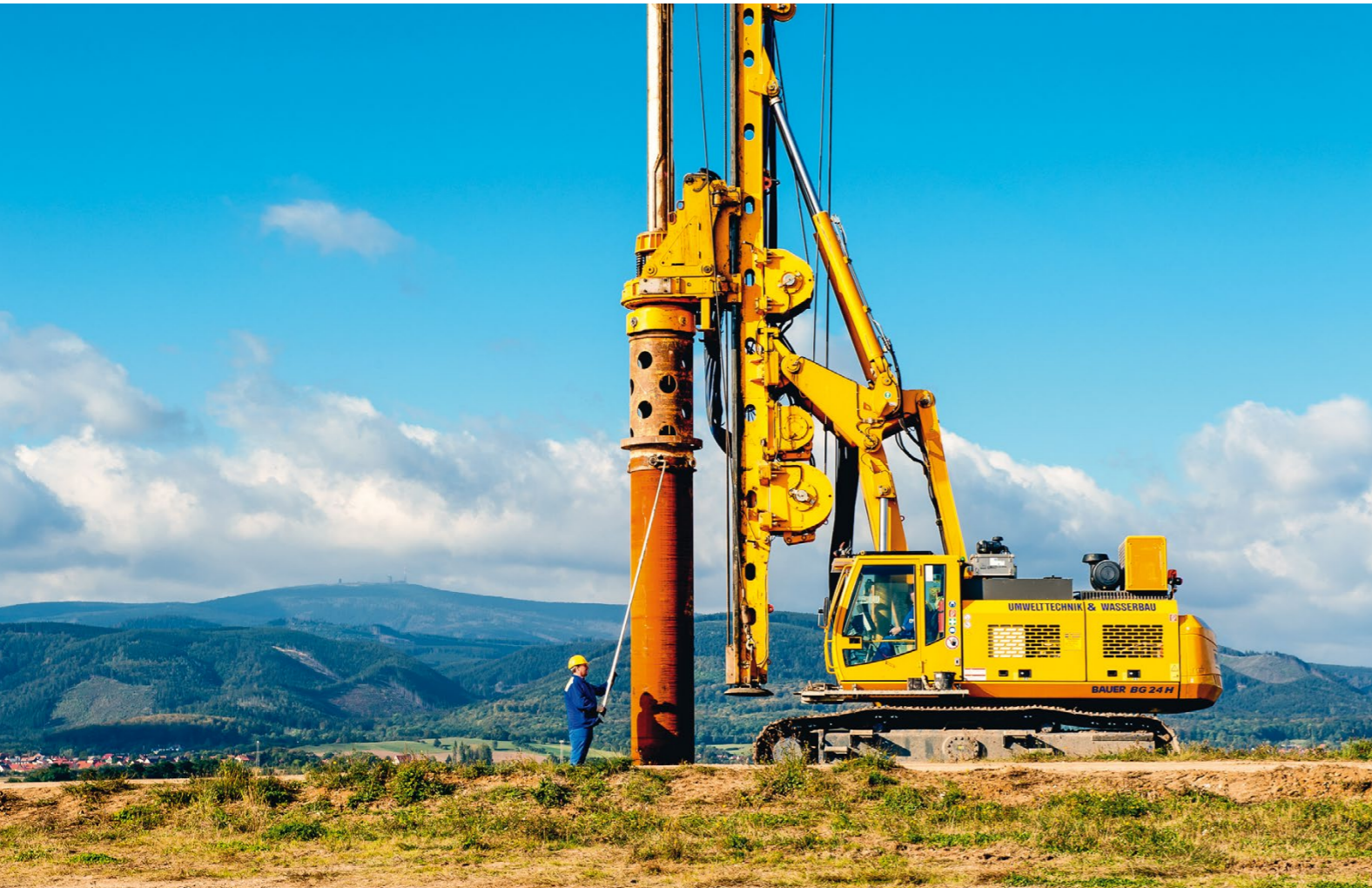
Deponie Wernigerode – Großdrehbohrgerät BG 24
