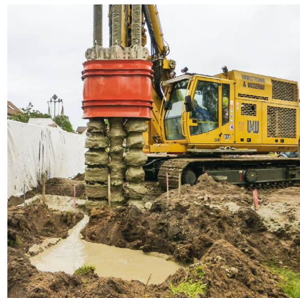
Wustrow – Bodenmischverfahren für Baugrubenverbau mit Dreifach Mischpaddel
