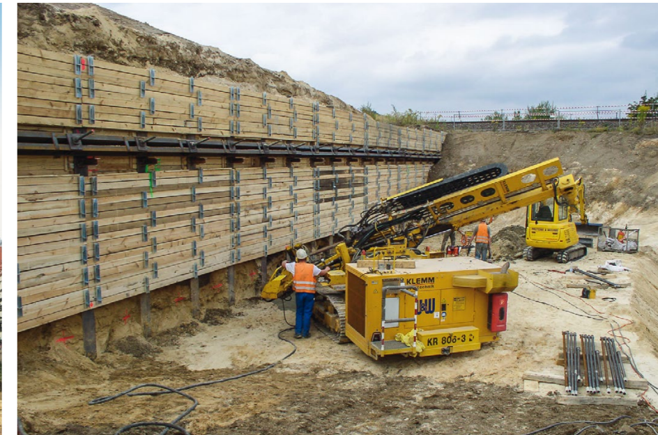
Blankenburg, Zufahrt Harzkaserne Trägerbohlwand mit Verankerung
