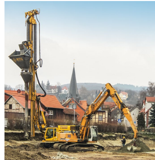
Wernigerode, Rüttelstopfverdichtung für die Gründung der Zindel-Turnhalle
