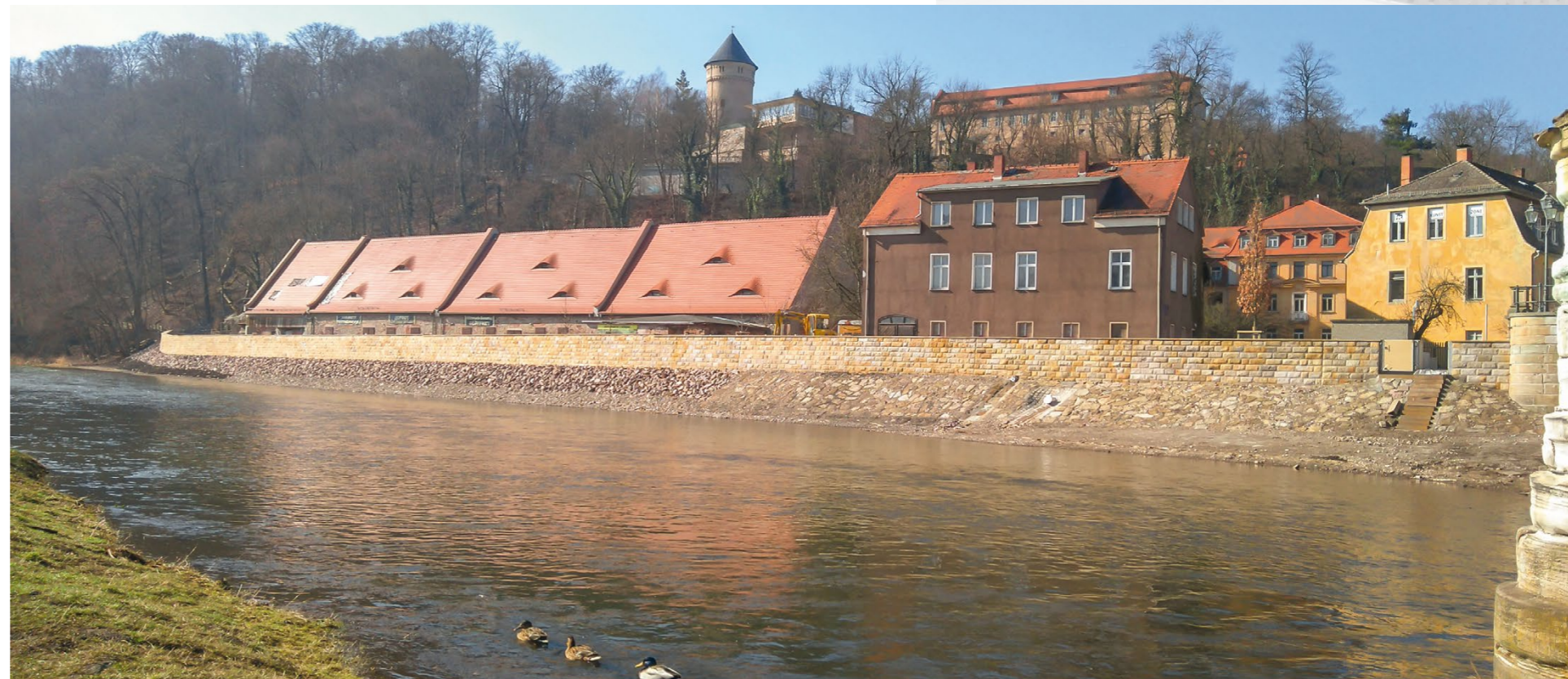
Hochwasserschutzwand Gera Weiße Elster
