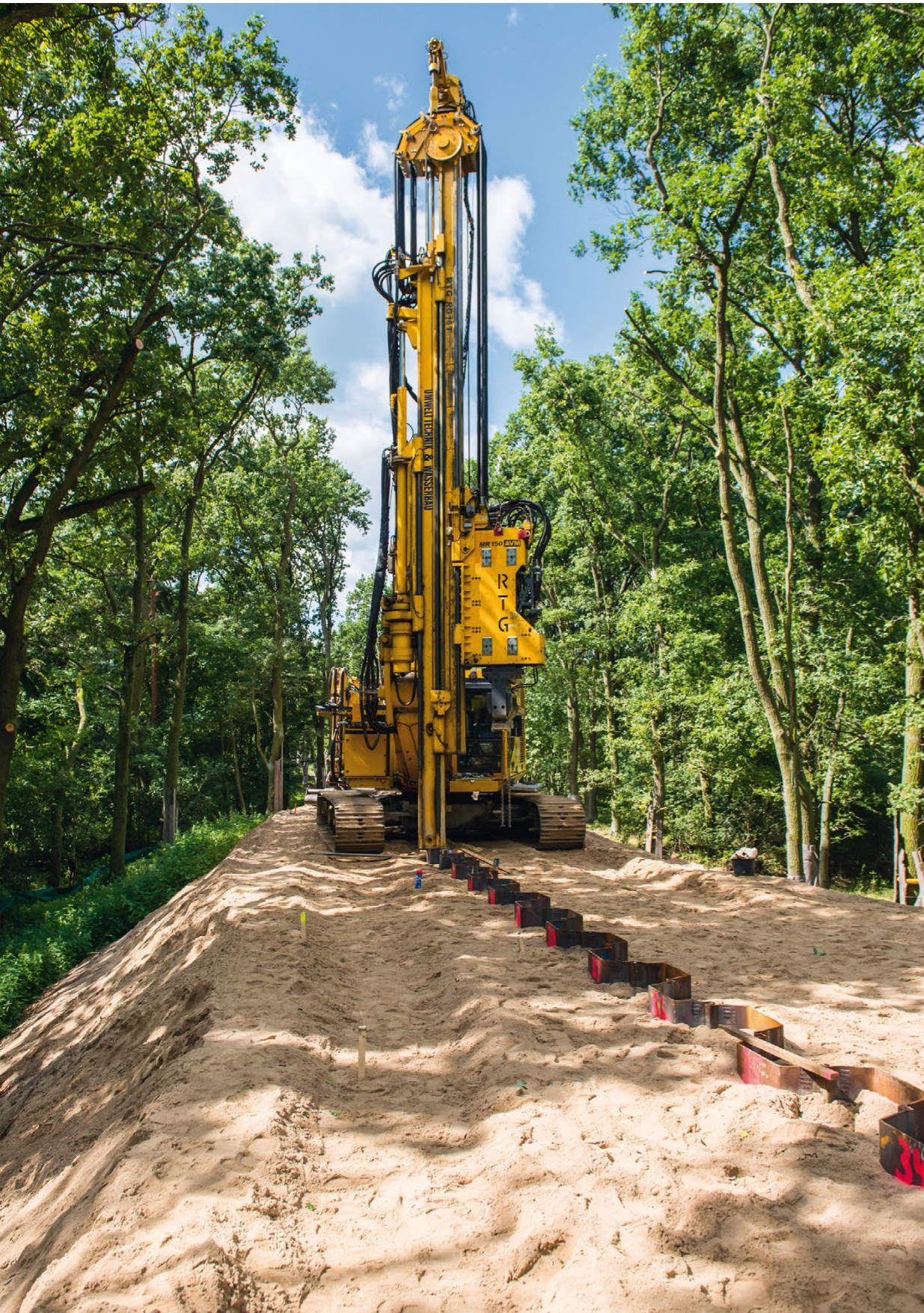
Sanierung Elbdeich bei Hinzdorf, Hochwasserschutzdeich mit Dichtwand aus Spundbohlen
