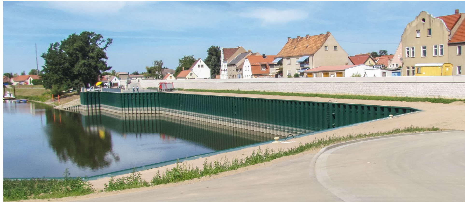
Sanierung des Elbdeiches im Raum Mühlberg
