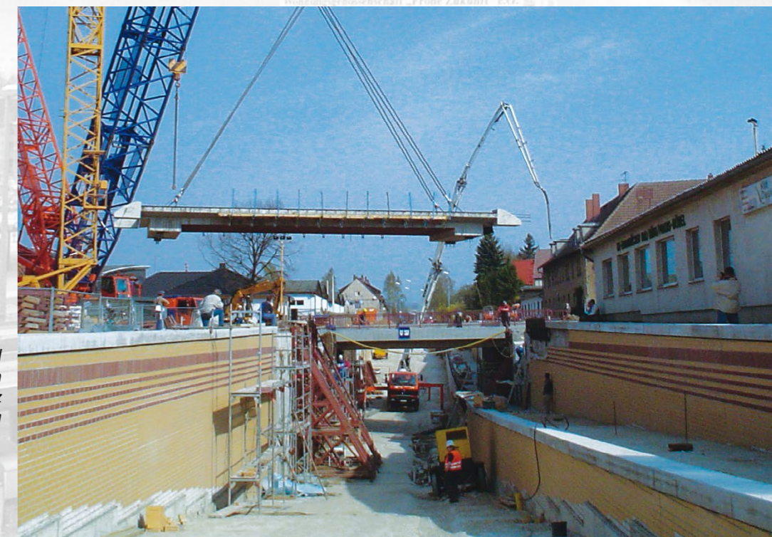
Brückenmontage am Veckenstedter Weg in Wernigerode
