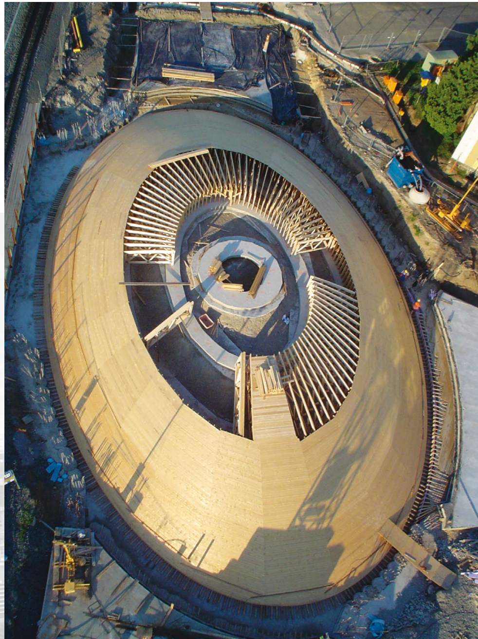
Schalungstechnik für Kuppelbauwerk Altstadtkreisel Wernigerode
