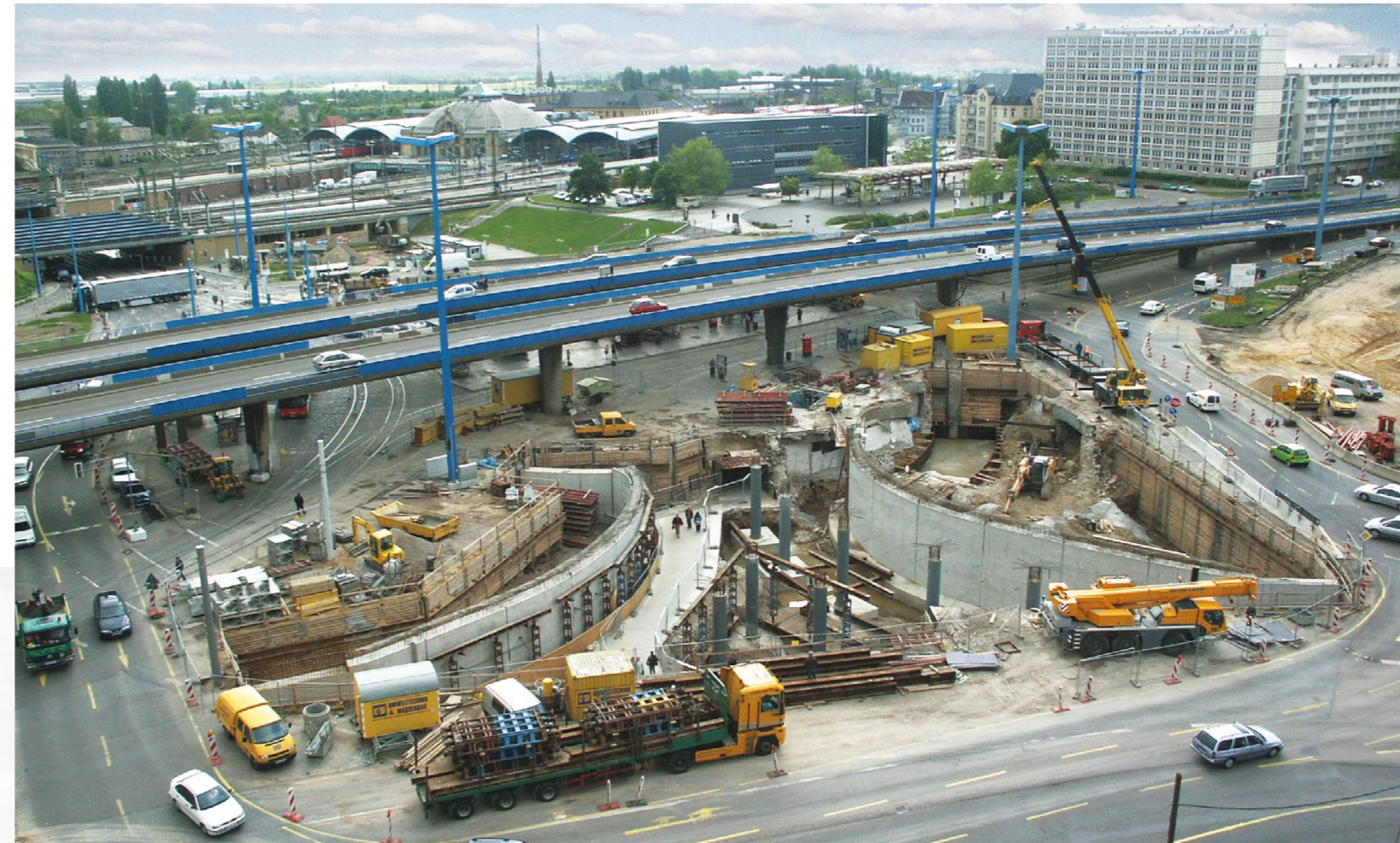
Großbaustelle Riebeckplatz in Halle
