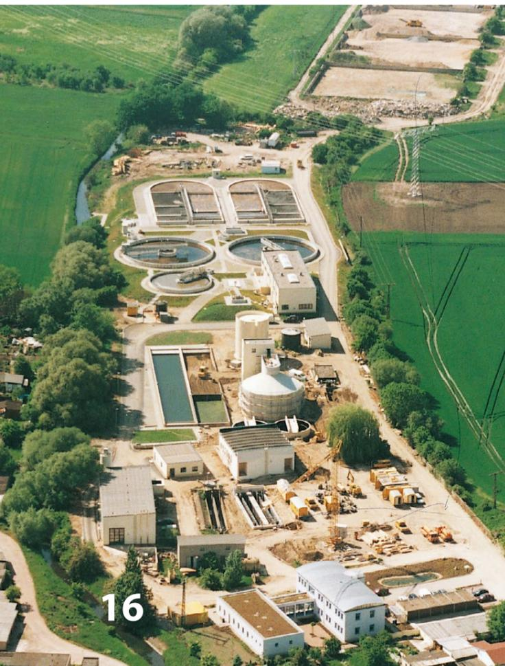
*Grubenwasserreinigungsanlage 45–60 m<sup>3</sup>/min in Schleenhain*
