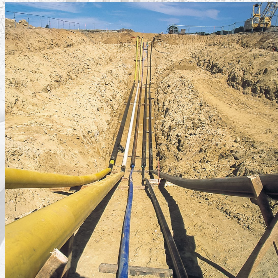
Medienleitungen B6n in Blankenburg
