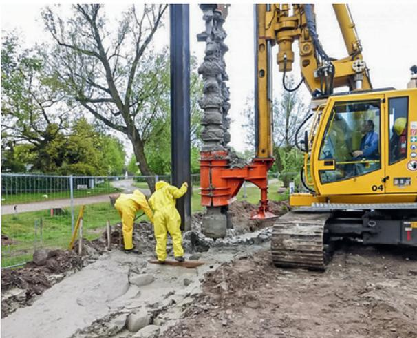
*Wustrow – Bodenmischverfahren für Baugrubenverbau mit Dreifach-Mischpaddel*
