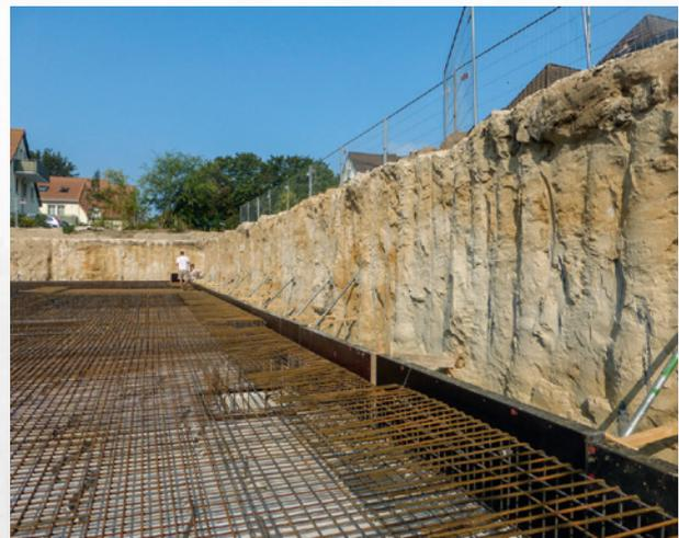
*Baugrube in Wustrow – Baugrubenumschließung mittels Bodenmischverfahren*
