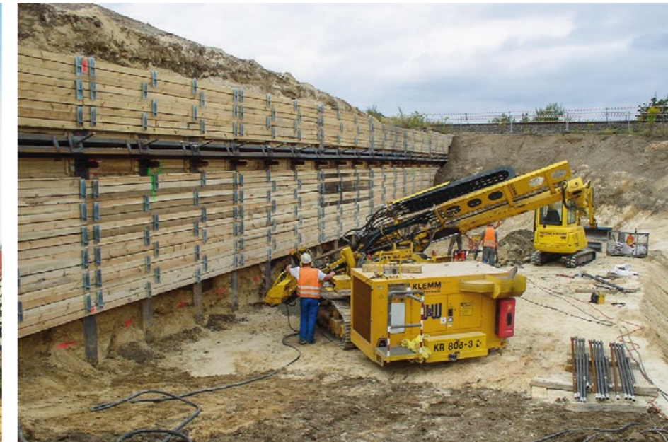
Blankenburg, Zufahrt Harzkaserne Trägerbohlwand mit Verankerung
