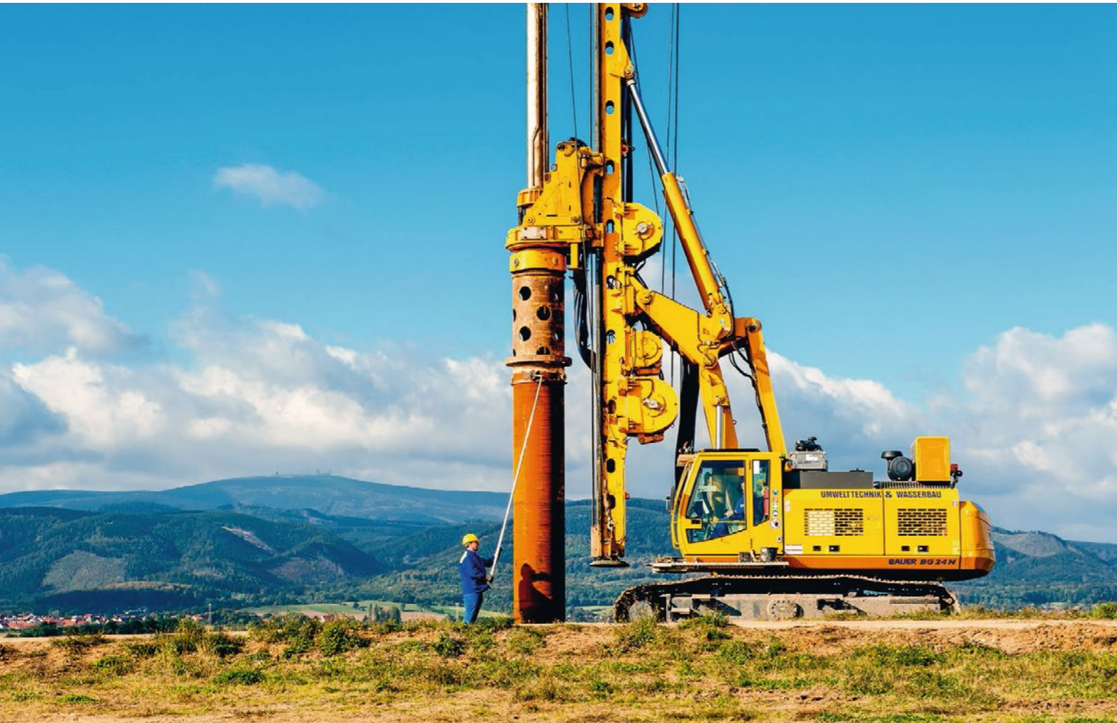
Deponie Wernigerode – Großdrehbohrgerät BG 24
