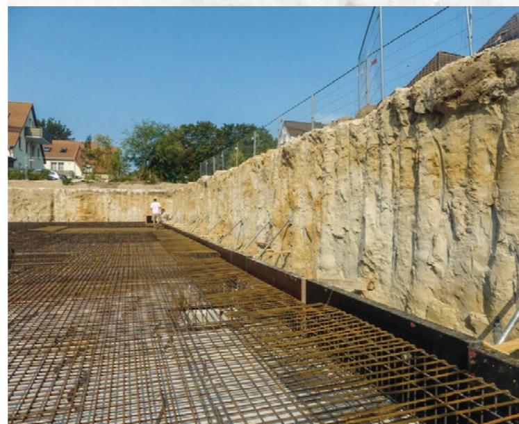
Baugrube in Wustrow – Baugrubenumschließung mittels Bodenmischverfahren
