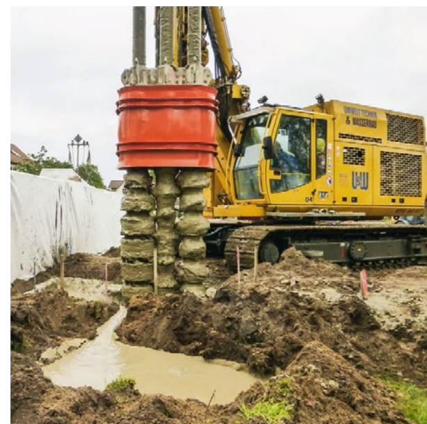
Wustrow – Bodenmischverfahren für Baugrubenverbau mit Dreifach Mischpaddel
