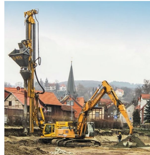
Wernigerode, Rüttelstopfverdichtung für die Gründung der Zindel-Turnhalle
