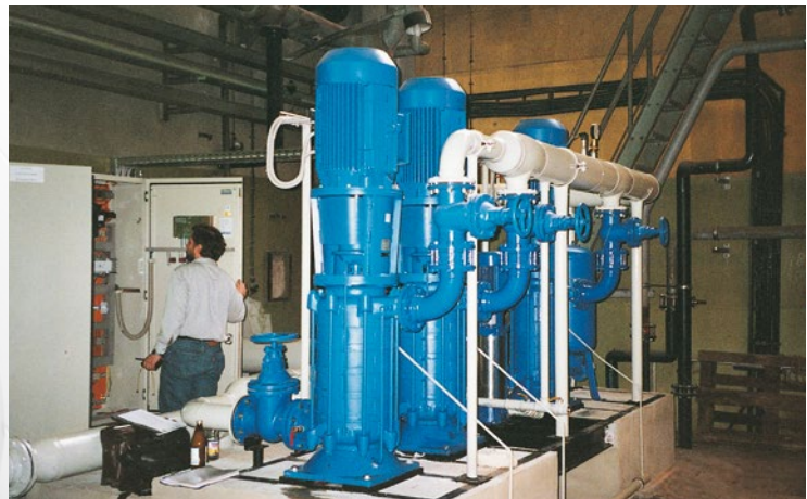
Feuerlöschpumpe Kraftwerk Lippendorf
