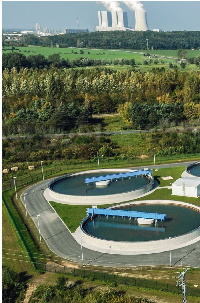
Grubenwasserreinigungsanlage 45–60 m 3 /min in Schleenhain
