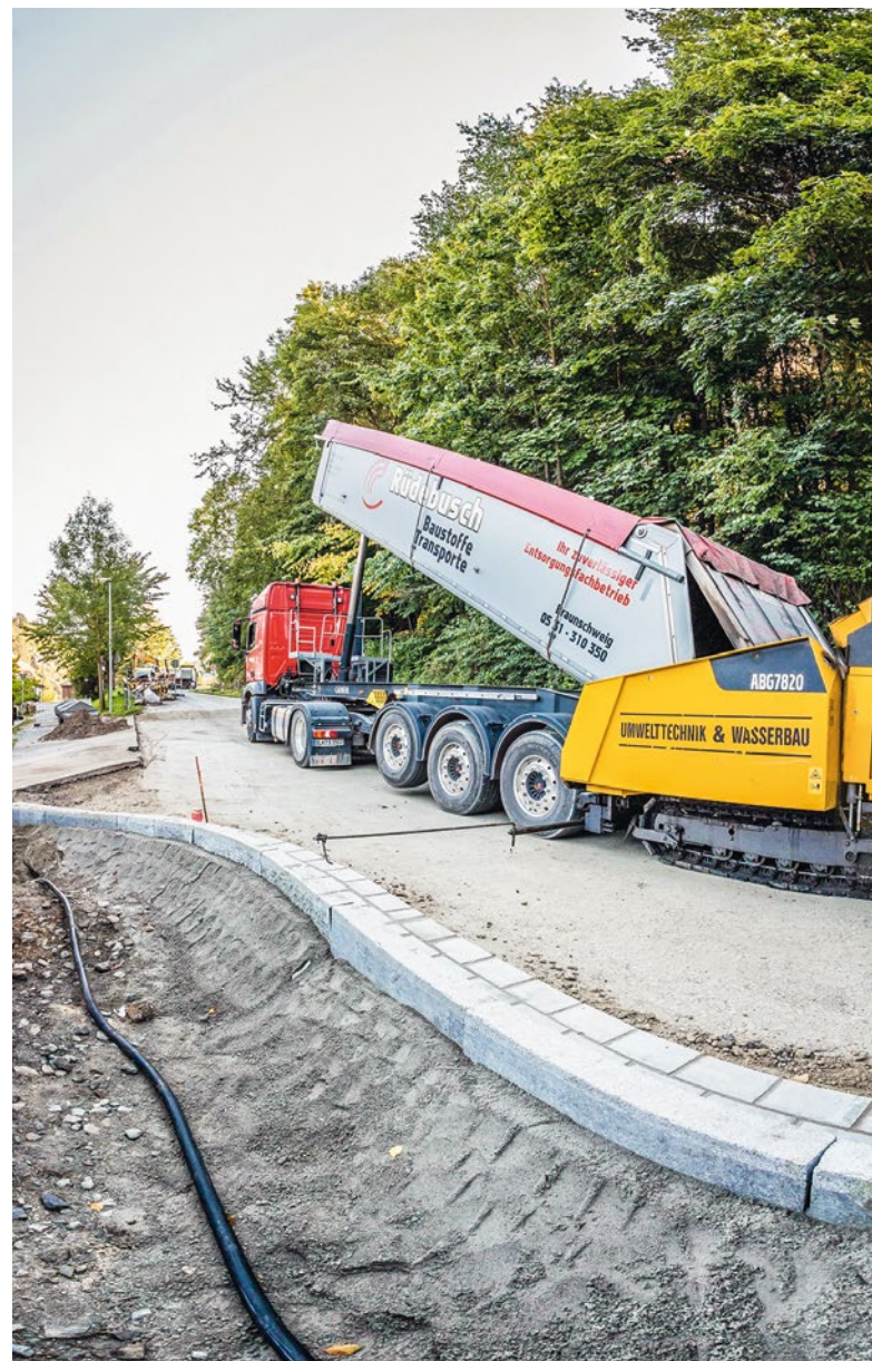
Ausbau der L96 bei Rübeland Asphaltfertiger Volvo TITAN 7820
