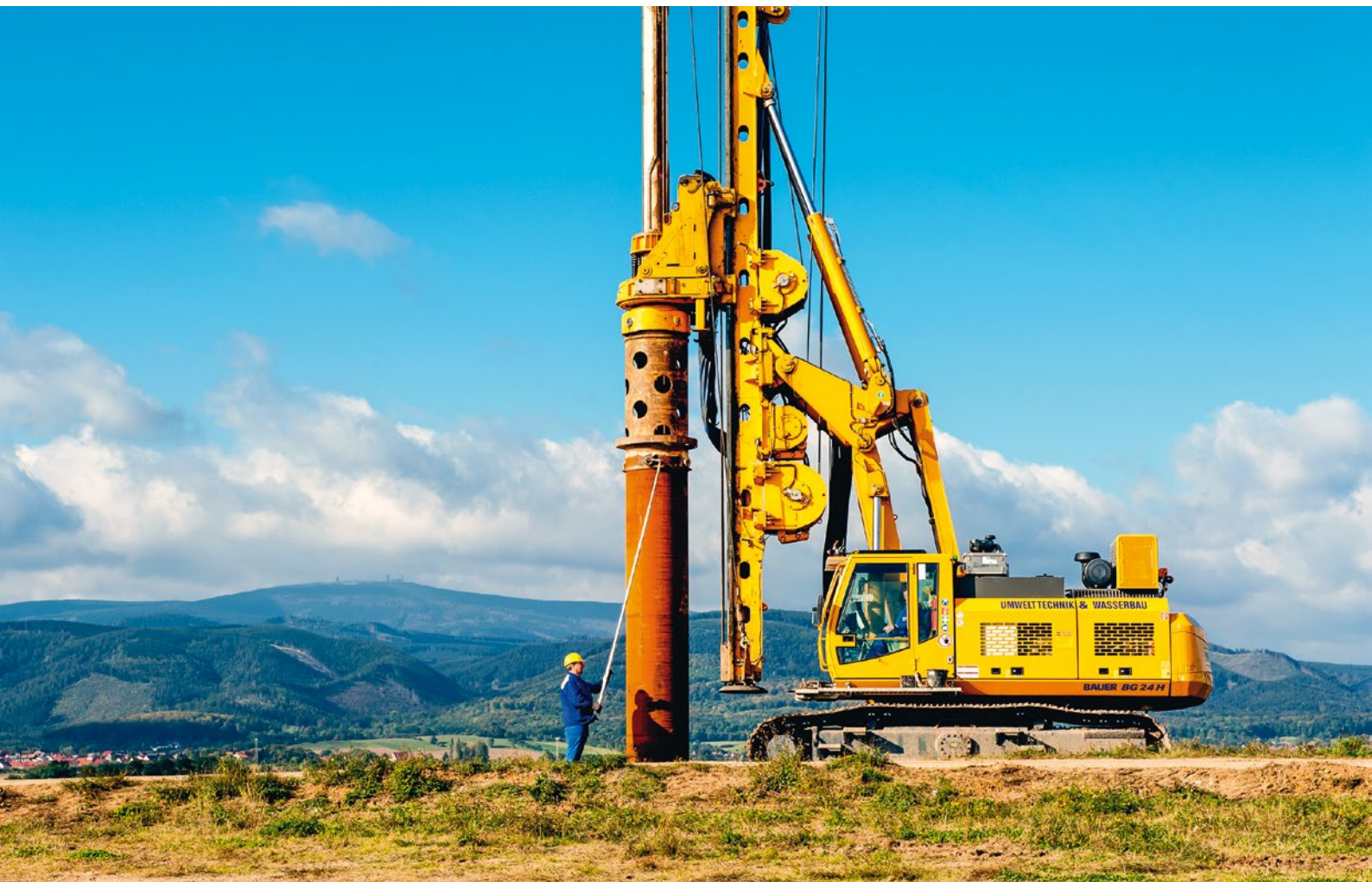
Deponie Wernigerode – Großdrehbohrgerät BG 24
