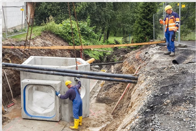
Steinzeugrohrleitung DN 400 in Halle (Saale)
