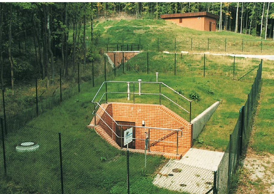
Wasserhochbehälter Tiergarten Blankenburg 2 \times 500 \text{ m}^3
