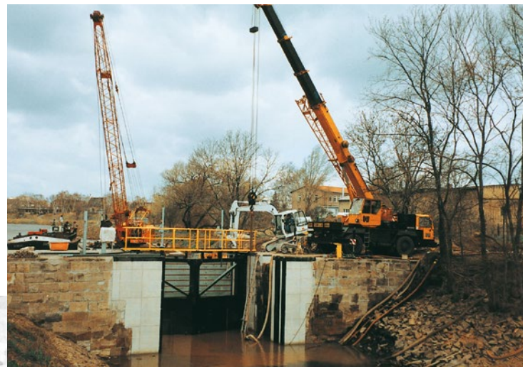
Sanierung Fangschleuse Halle-Trotha
