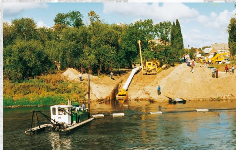
Saale-Düker bei Nienburg aus Stahlrohr DN 800
