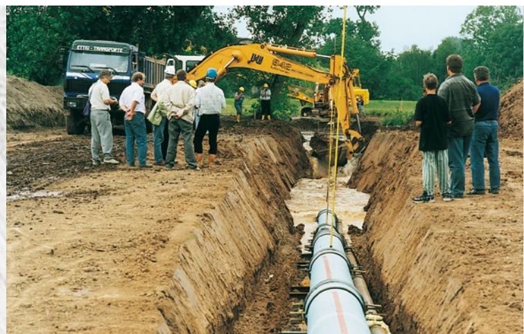
Düker Weiße Elster aus Gussrohr DN 400
