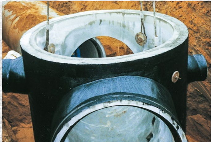
Kanalbau Schkeuditz DN 2000
