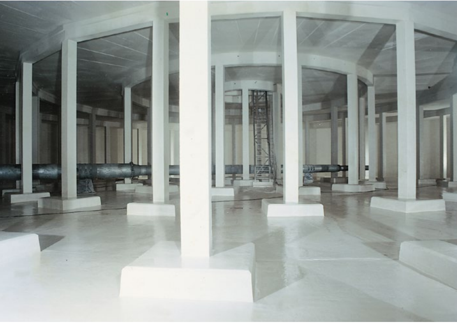
Wasserhochbehältergruppe Wienrode Innenansicht, 2 \times 12.500 \text{ m}^3
