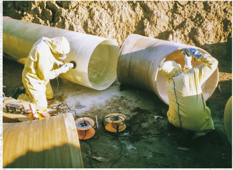
Rohwasserleitung GFK-Rohre DN 800
