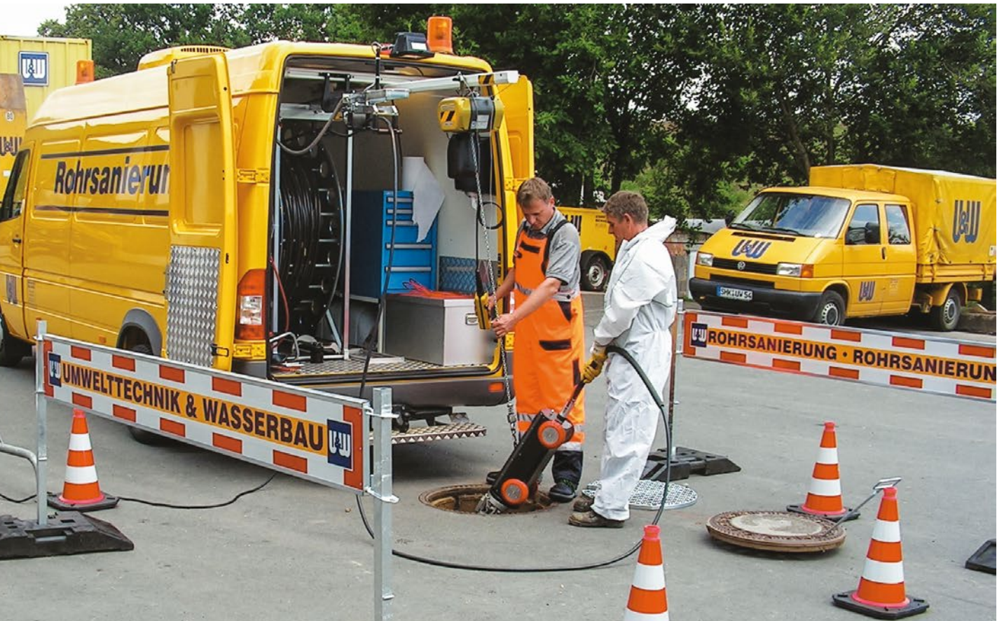
Rohrsanierungstechnik mit Spachtel- und Fräsrobotern DN 150-600
