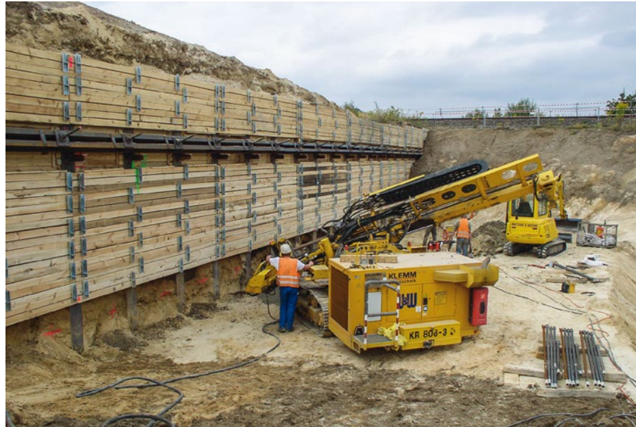
Blankenburg, Zufahrt Harzkaserne Trägerbohlwand mit Verankerung
