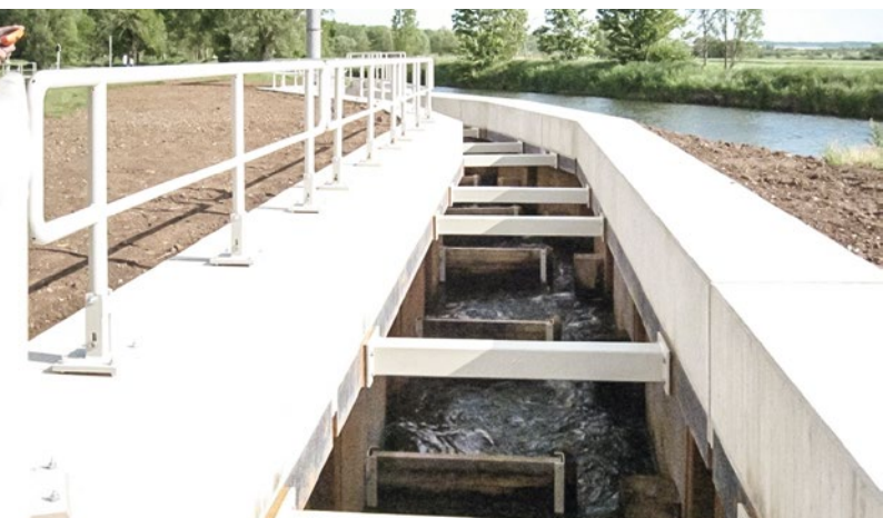
Stahlbauarbeiten für den Beckenpass einer Fischaufstiegsanlage
