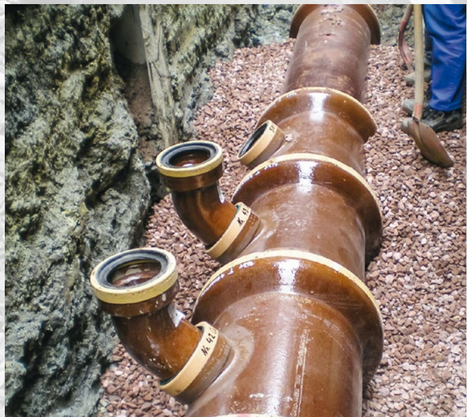
Steinzeugrohrleitung DN 400 in Halle (Saale)
