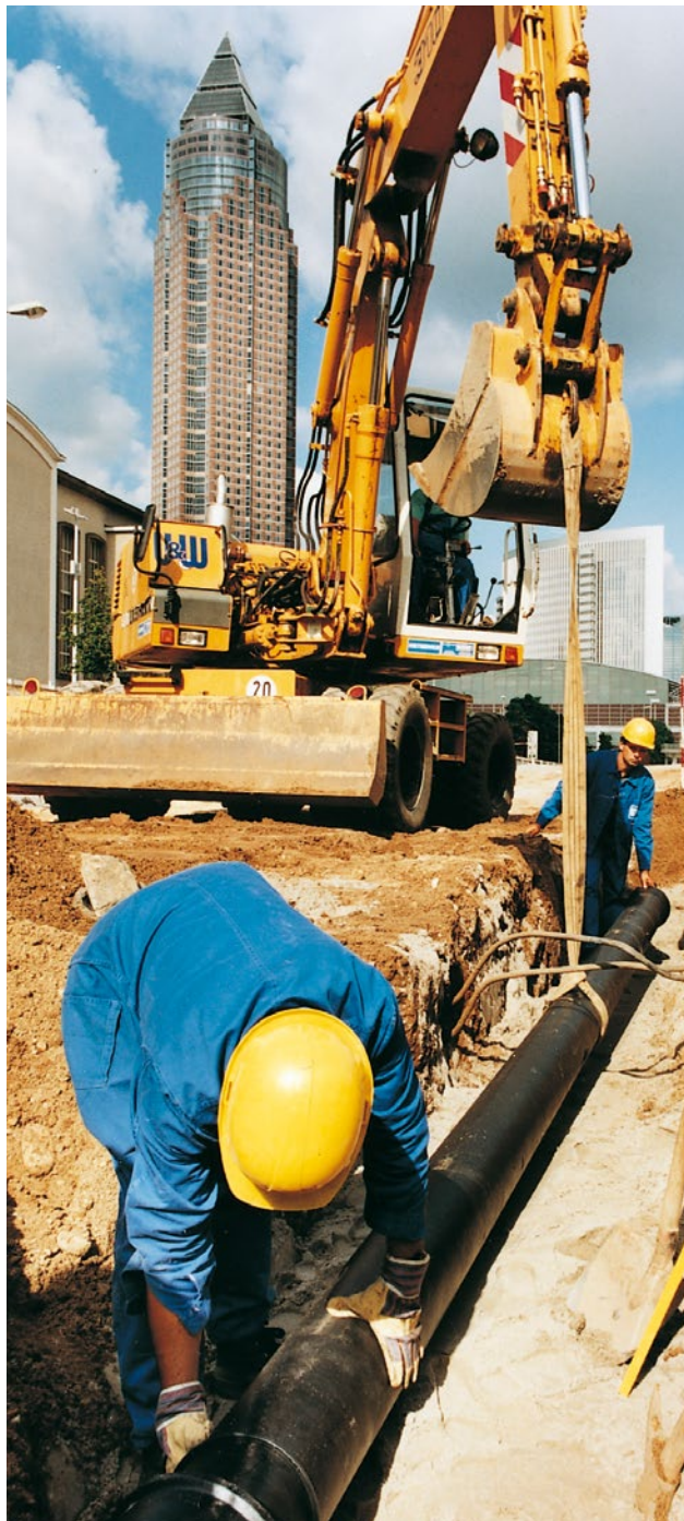
Abb. oben: Wasserleitungsverlegung in Frankfurt am Main
