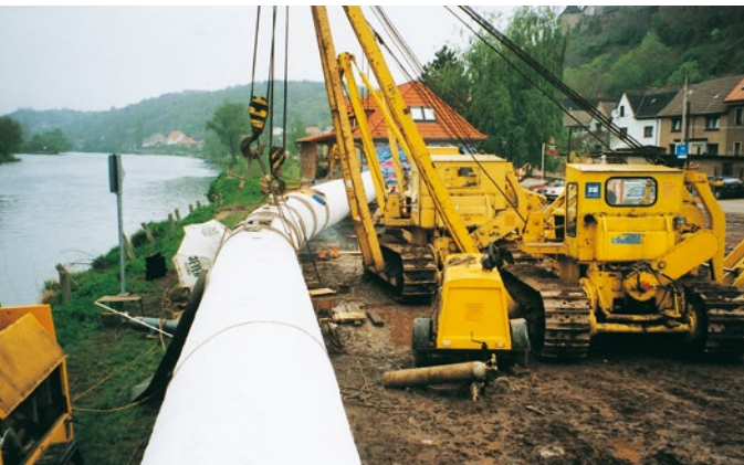
Vorfertigung Saale-Düker bei Halle
