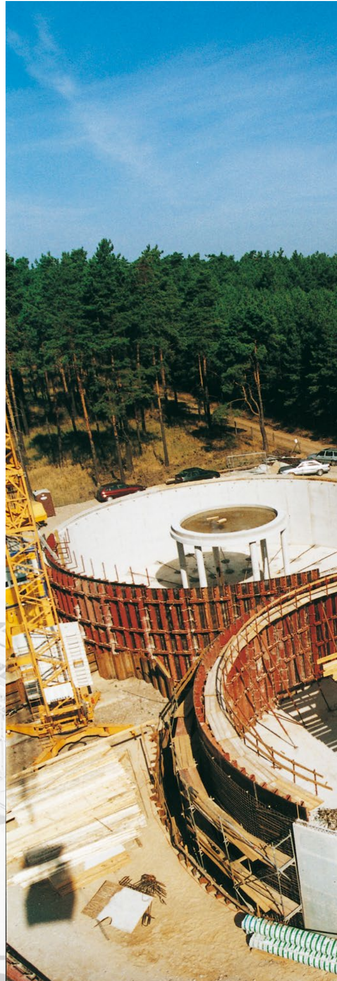
Abb. rechts: Wasserhochbehälter Kreuzberge 2 \times 2.000 \text{ m}^3 (Fernwasserleitung Lindau – Lutherstadt Wittenberg)
