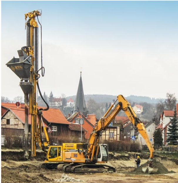
Wernigerode, Rüttelstopfverdichtung für die Gründung der Zindel-Turnhalle
