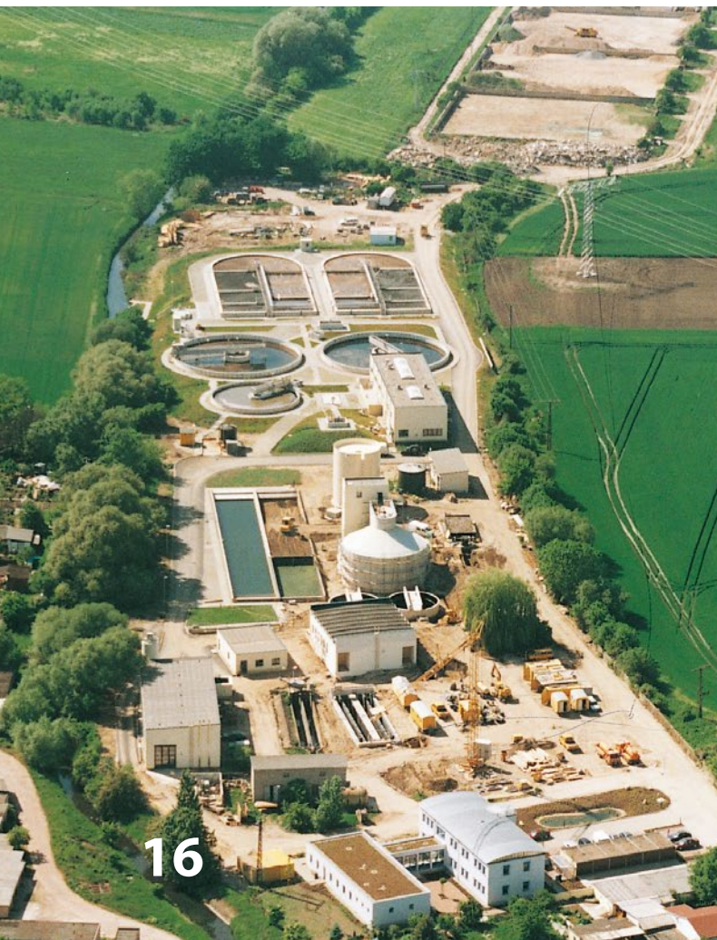
Kläranlage Köthen 45.000 EW
