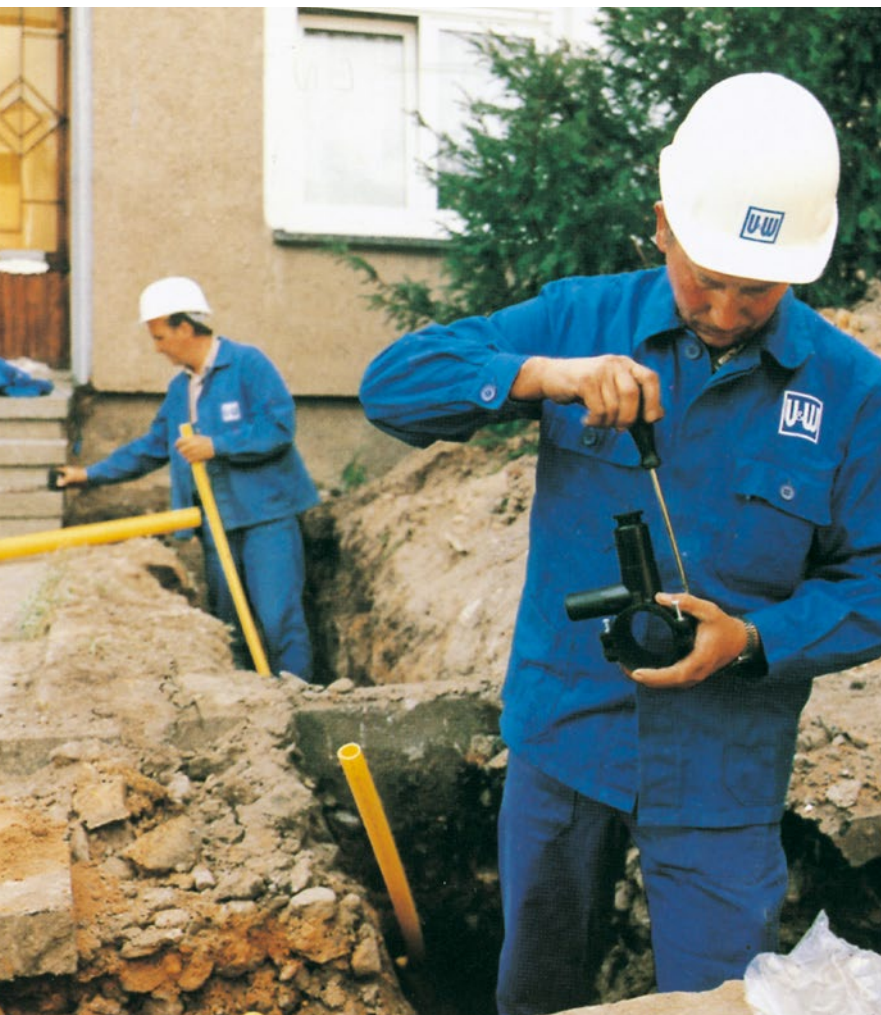
Verlegung Gas-Hausanschlüsse in Jena
