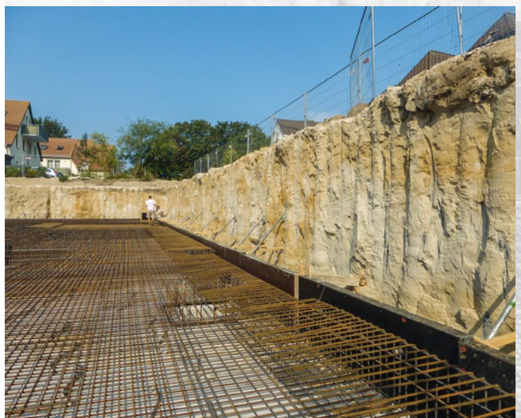
Baugrube in Wustrow – Baugrubenumschließung mittels Bodenmischverfahren
