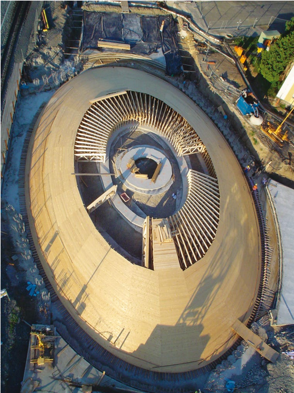
Schalungstechnik für Kuppelbauwerk Altstadtkreisel Wernigerode
