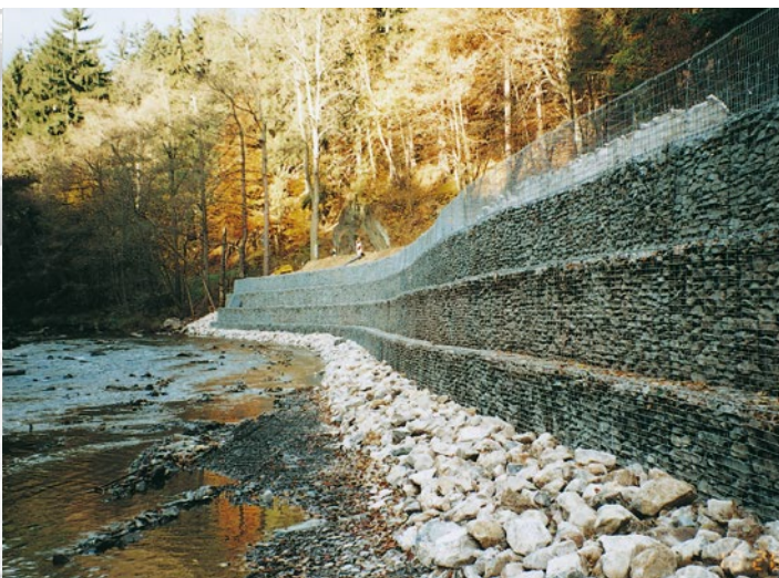
Gabionenwand: naturnahe Stützwand als Böschungssicherung an der Bode bei Altenbrak
