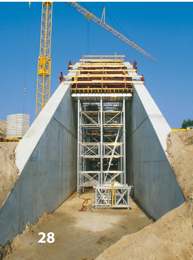
Einlaufbauwerk Lohsa II
