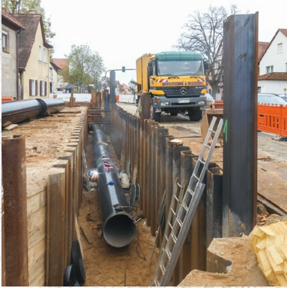
Trinkwasserleitung DN 900 in Rückersdorf
