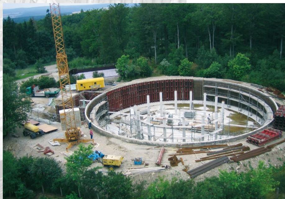
Sanierung Hochbehälter Friedrichsbrunn 2 \times 2.250 \text{ m}^3
