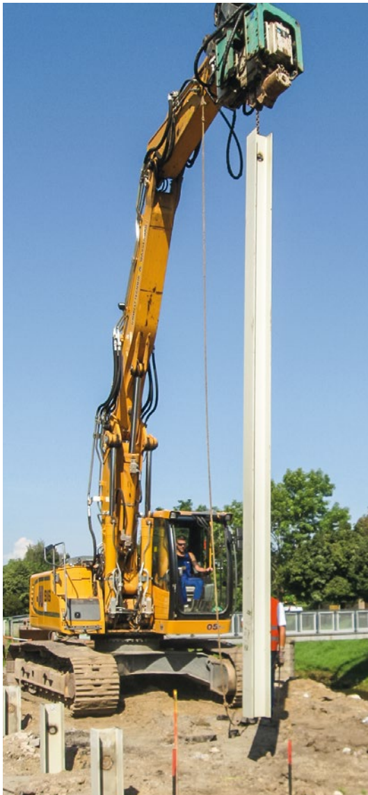
Arbeiten mit Anbauvibrationsramme
