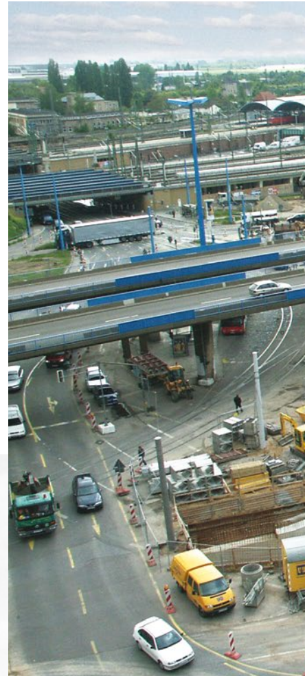
Großbaustelle Riebeckplatz in Halle
