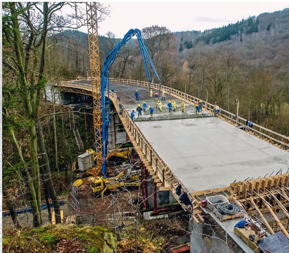
Brücke über das Schiefe Tal zwischen Meisdorf und Pansfelde
