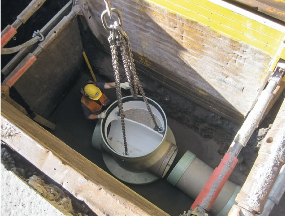
Schachtbaugrube GFK DN 600 Clausthal-Zellerfeld
