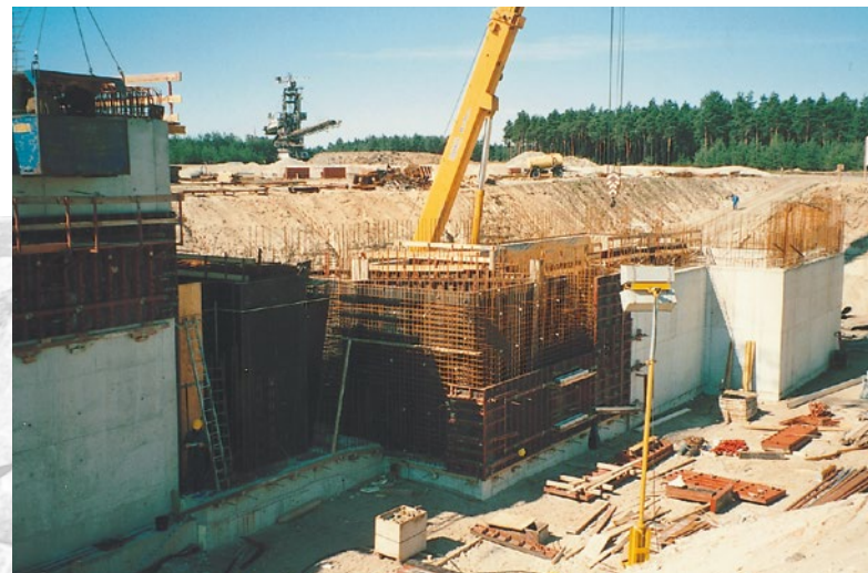
Einlaufbauwerk Bewehrungsarbeiten
