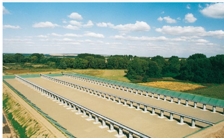
Klärschlammvererdungsbecken Quedlinburg 30.000 EW, Fläche 15.000 m 2
