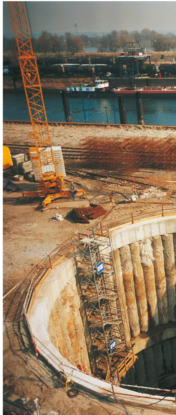
Pumpwerk Hauptsammler Nord Magdeburg Schachtbauwerk als überschnittene Bohrpfehlwand (Bohrpfähle 1,20 m, 25 m tief)
