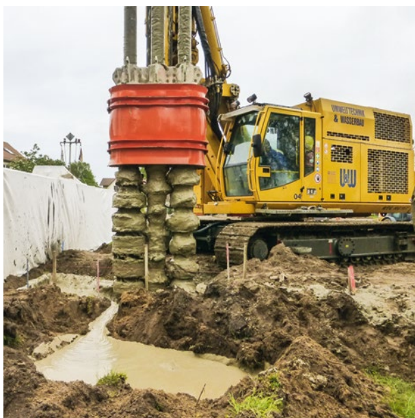
Wustrow – Bodenmischverfahren für Baugrubenverbau mit Dreifach Mischpaddel
