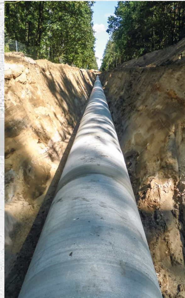
Haupttransportleitung Trinkwasserversorgung Burgkennitz
