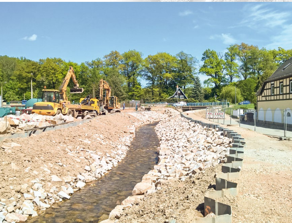
Hochwasserschutz Aubach Greiz
