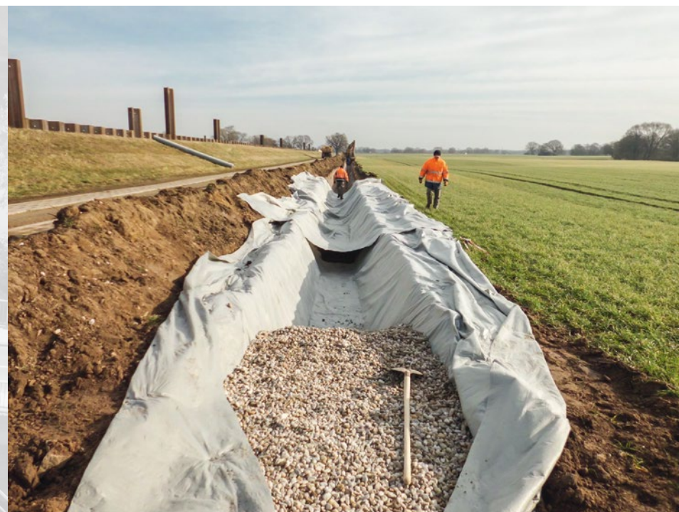
Instandsetzung linker Muldedeich von Löbnitz bis Bad Dübén
