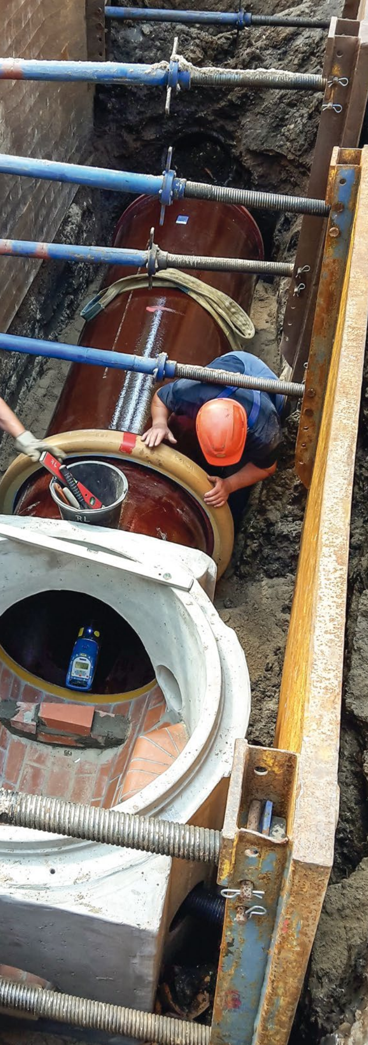
Mischwasserhauptsammler Leipzig - Leutzsch
