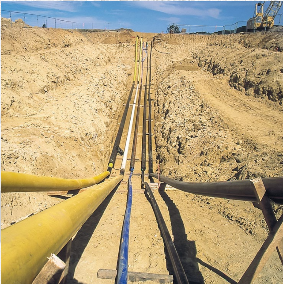
Medienleitungen B6n in Blankenburg
