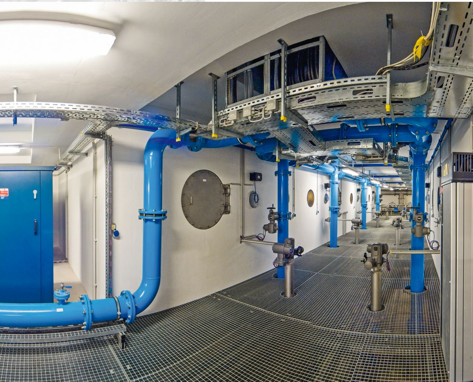
Feuerlöschpumpe Kraftwerk Lippendorf
