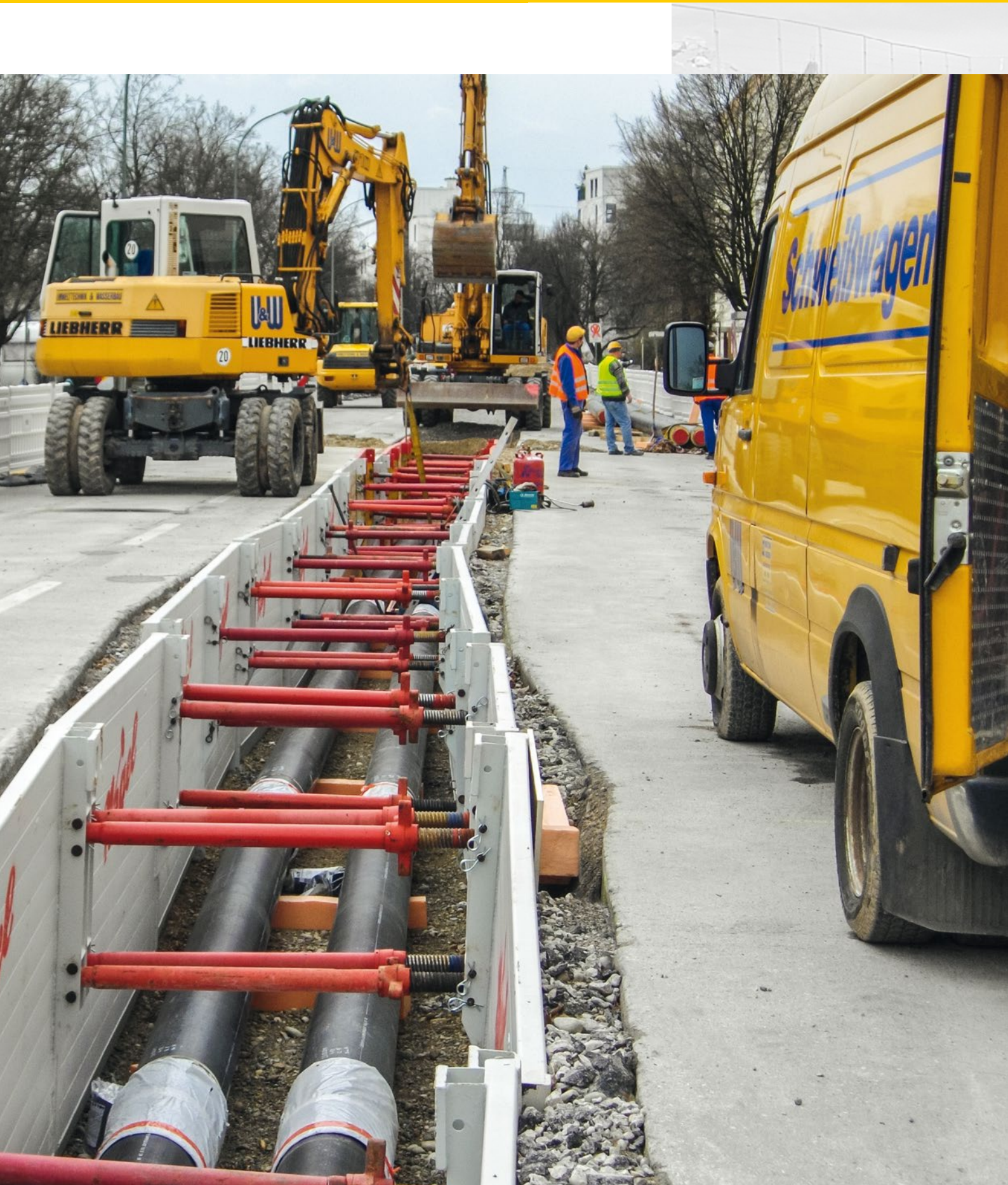
Fernwärmeleitung Stadtwerke München KMR DN 250
