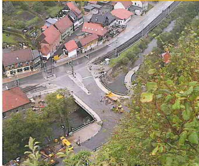
Als Ersatzneubau der Bodebrücke wurde ein einfeldriger, flach gegründeter Rahmen mit Zerrbalken realisiert. Der Überbau besteht aus schlaff bewehrtem Ortbeton. Widerlager und Flügel sind mit Natursteinverblendung aus ortstypischem Granit versehen. Auf dem Bauwerk ist ein Füllstabgeländer mit beleuchtetem Edelstahlhandlauf als Sonderkonstruktion angeordnet. In die Geländer sind Gestaltungselemente integriert. Gegenüber der alten Brücke hat sich die Verkehrsfläche mehr als verdoppelt.
